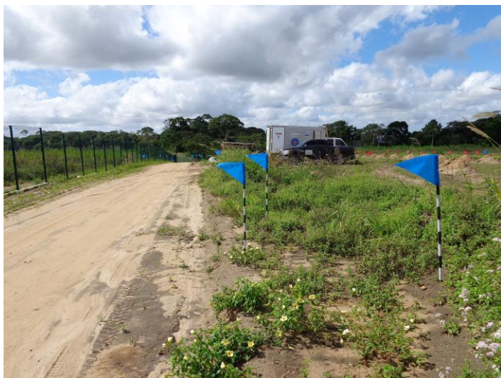
Figura 12 - Observe-se a remoção do solo na criação dos acessos.
