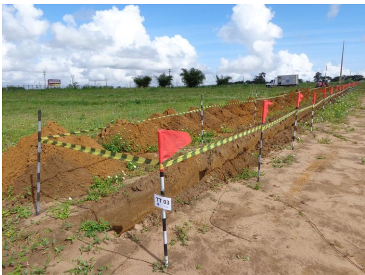
Figura 21 - Panorâmica da Trincheira Teste 03 (TT03)
