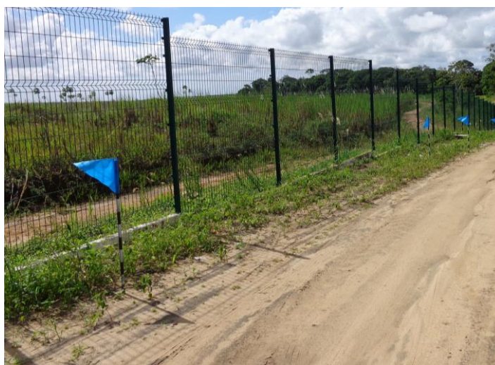
Figura 13 - Limite do empreendimento na área do sítio PE 0786 LA/UFPE. A esquerda, a estrada em desnível mais profundo do que o terreno no entorno.
